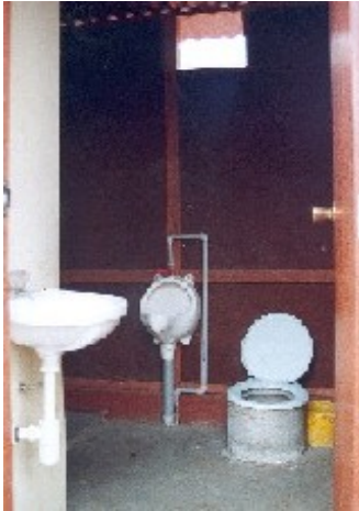
Fig. 4 foto de BES de doble cámara con ecoincinerador empotrado
