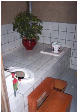
Fig. 5 Foto de BES con una sola cámara con Ecoincinerador para empotrar
