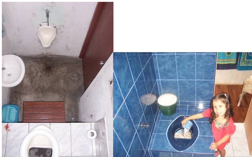
Fig. 5 Foto de BES con una sola cámara con Ecoincinerador para empotrar
